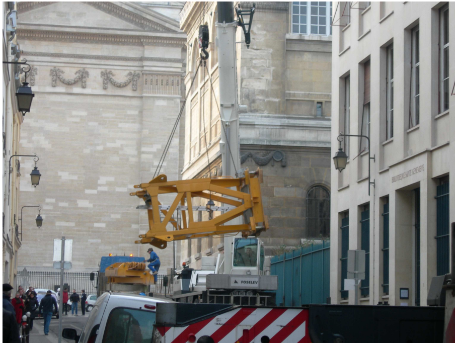
Installation de la grue rue Valette
